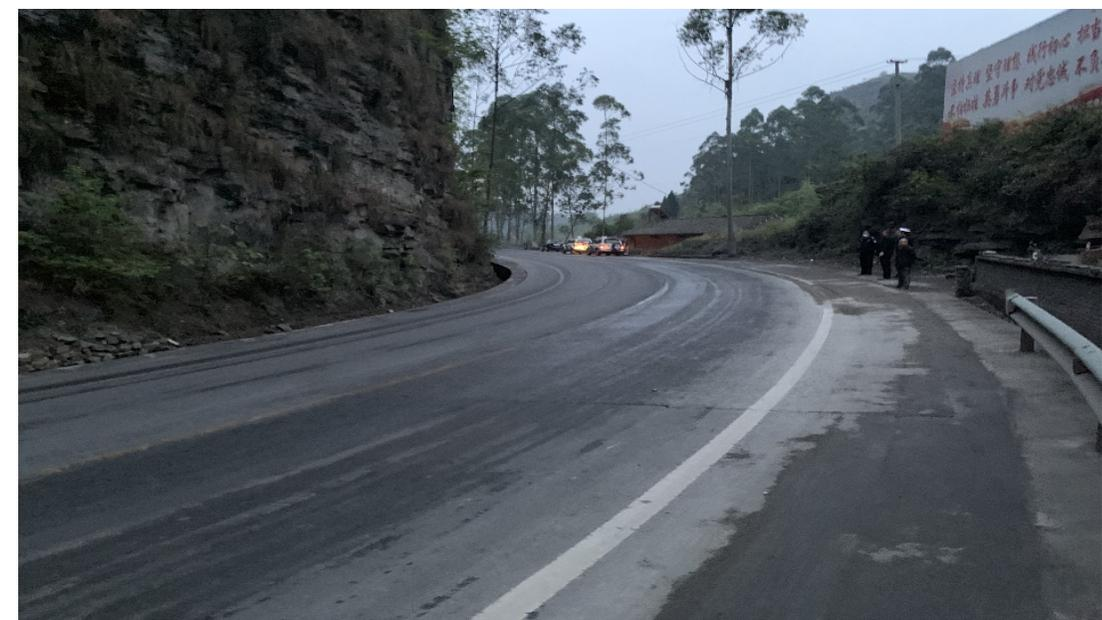
二级公路，设计速度40km/h，弯道半径50.125m
