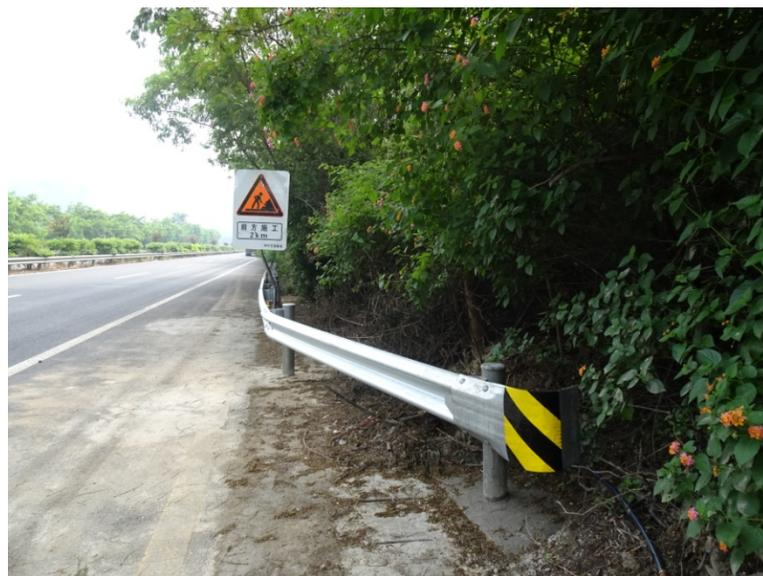
图 C.11 外展圆头式端头结构图示例(尺寸单位:mm)
