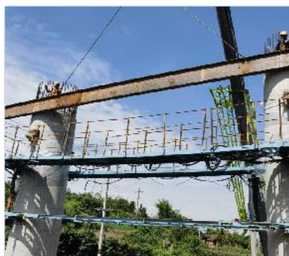
图 2 有平台后穿心棒施工工艺
