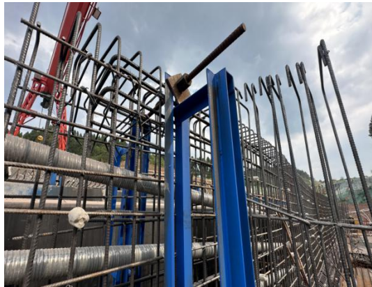
图 2 T 梁钢筋防倾覆装置正面
