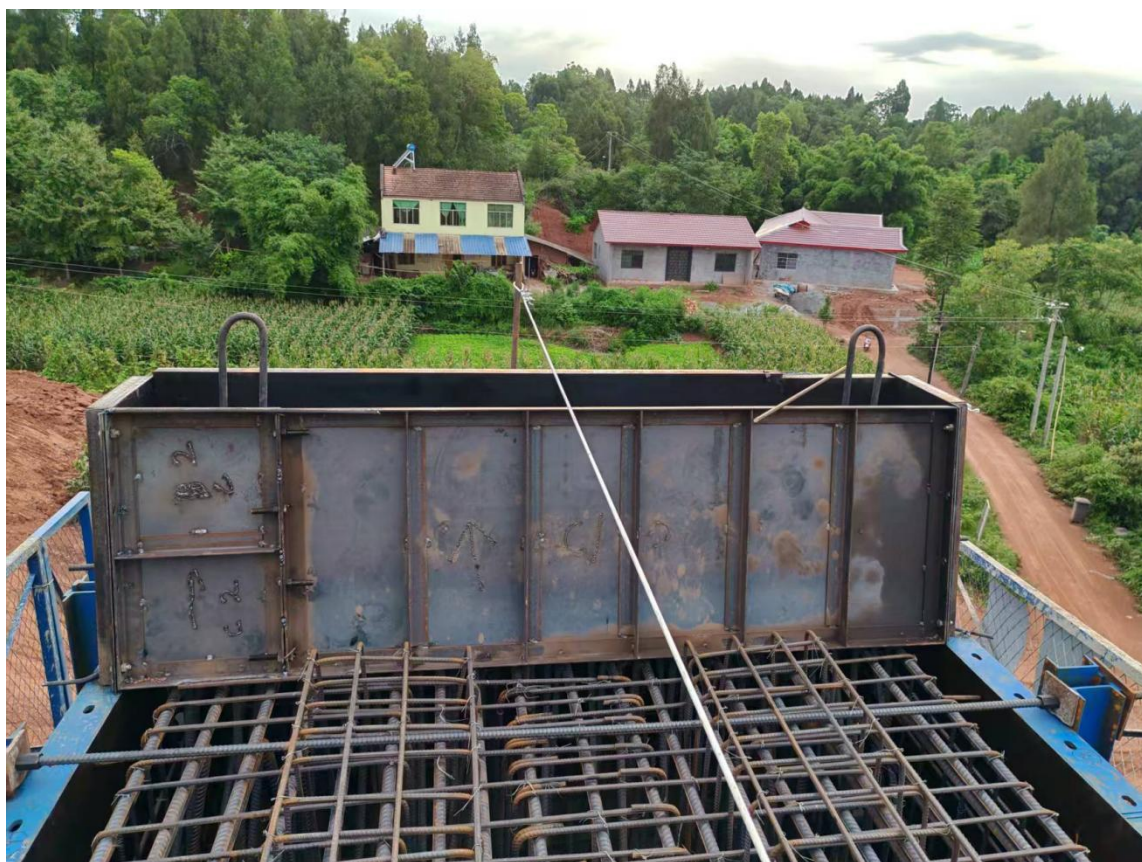
图 1 挡块模板与盖梁侧模刚性连接
