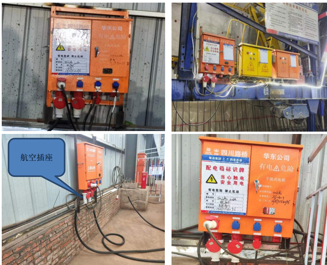
图 2 配备装配式三级配电箱并上墙
