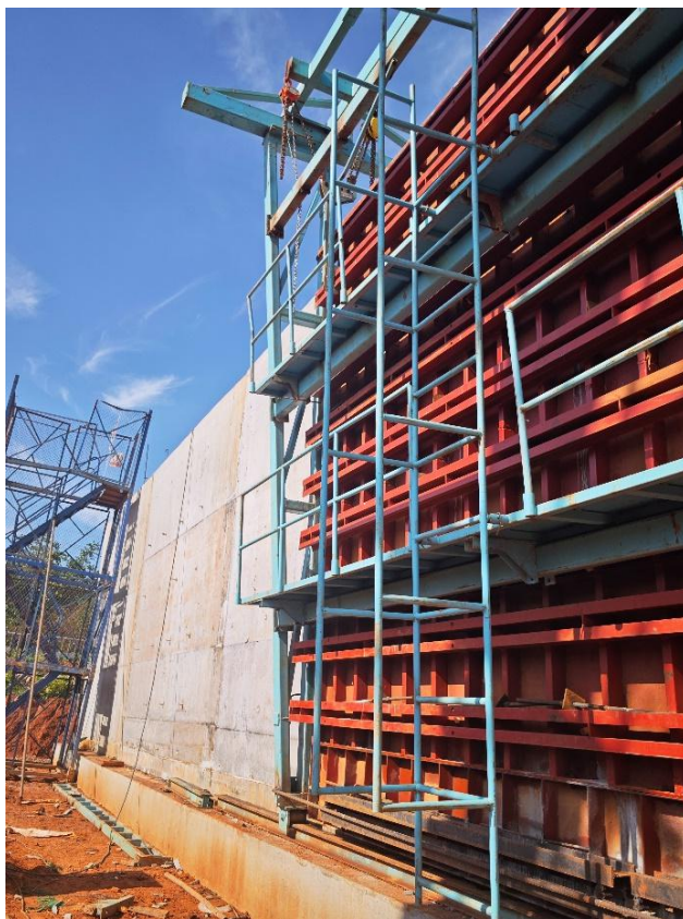
图7 台车操作平台安全防护
