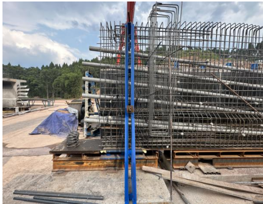
图 1 T 梁钢筋防倾覆装置侧面
