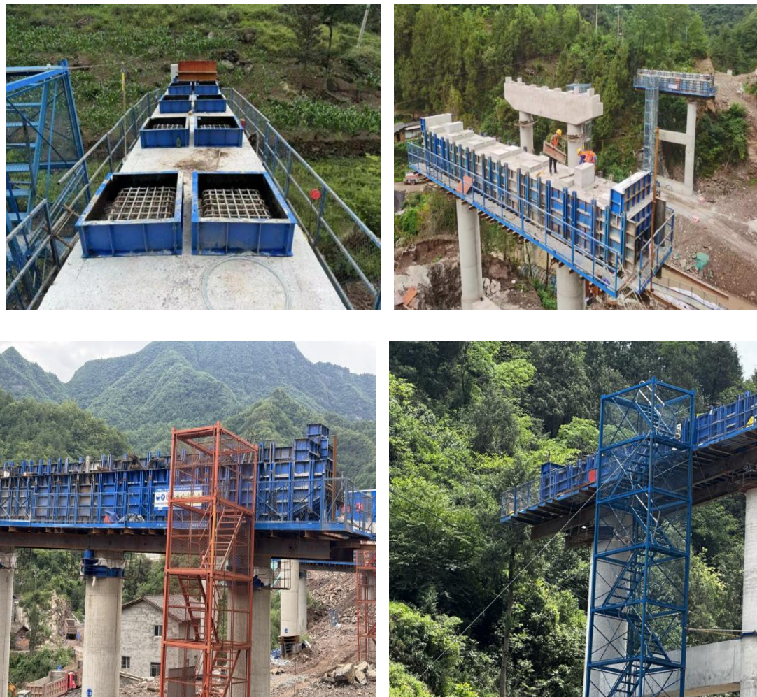
图 1 垫石同步施工图
