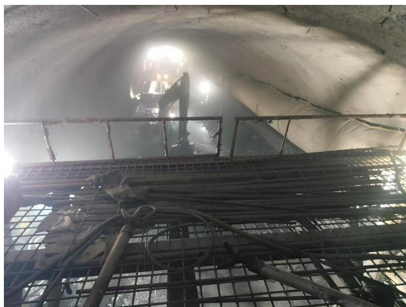
图 2 现场施工照片（防护栏杆安拆）
