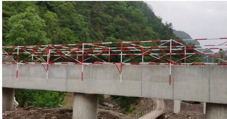
图 1 盖梁顶部临时护栏大样图
