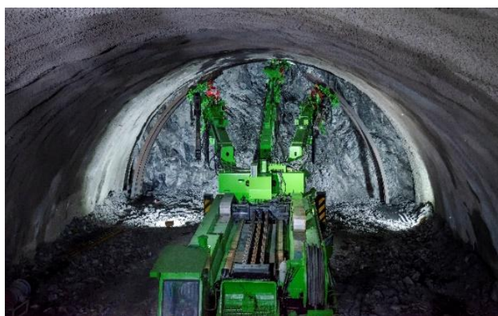
图3 拱架安装台车作业
