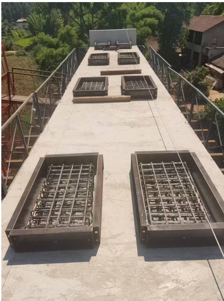
图 2 垫石施工利用盖梁防护体系
