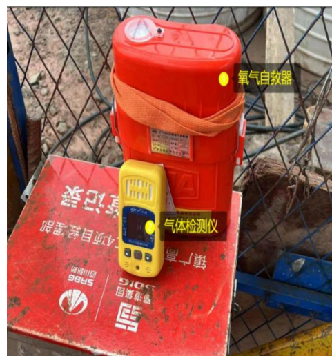
图 4 配备气体检测仪并设置氧气自救器
