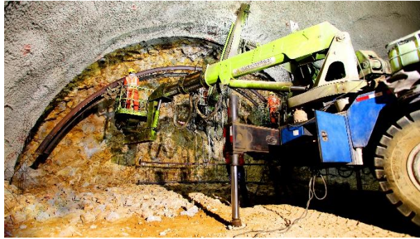
图 4 拱锚喷一体台车作业
