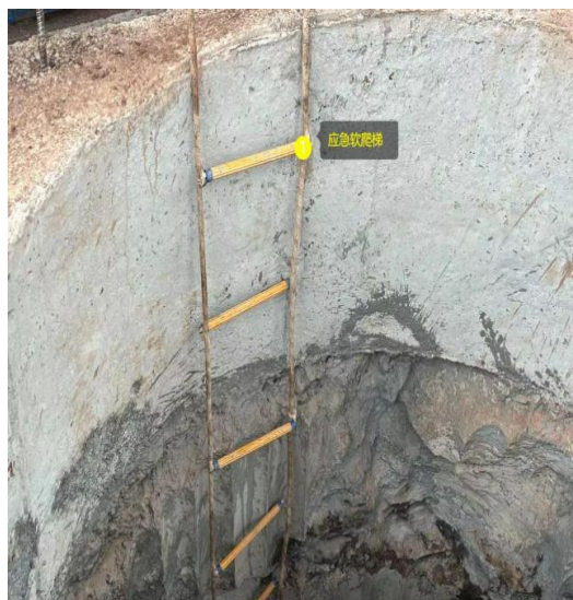
图 6 人工挖孔桩设置应急爬梯
