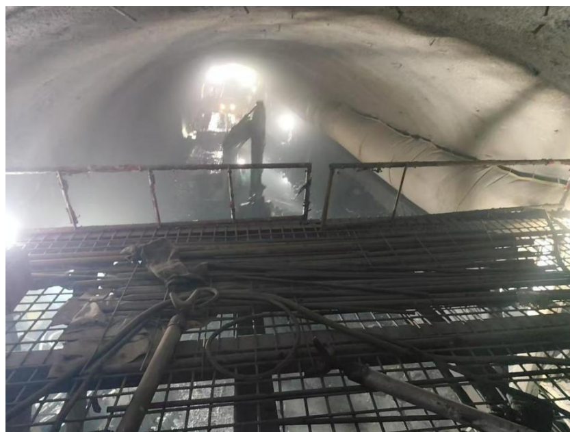
图 2 现场施工照片（防护栏杆安拆）
