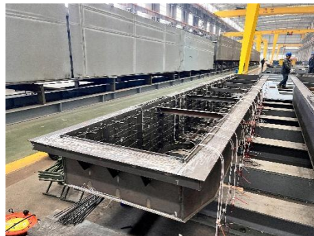
图 2 盖梁成型照片
