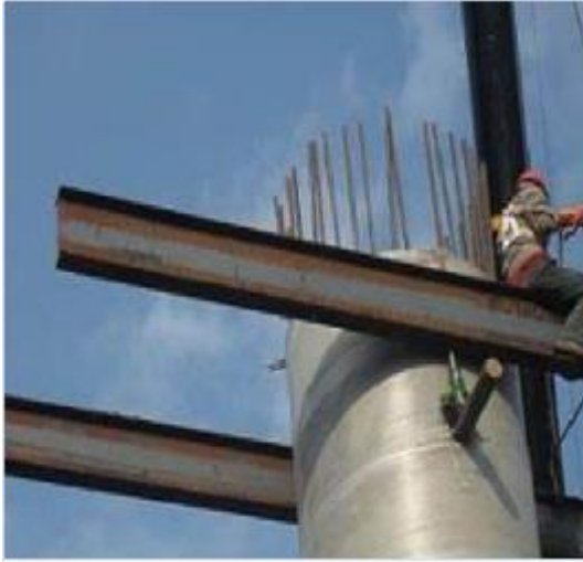
图 1 传统穿心棒施工工艺
