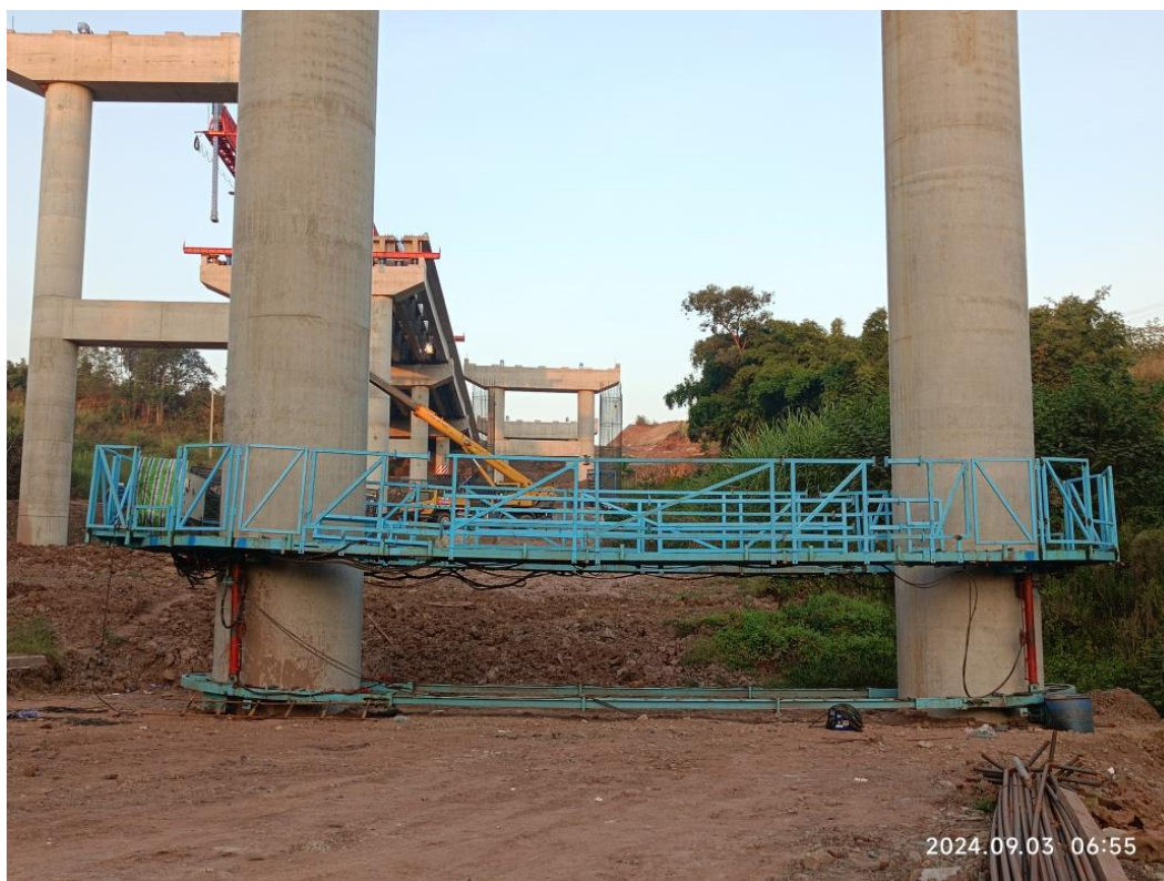
图 3 柱式墩下部结构施工自升降防坠作业平台
