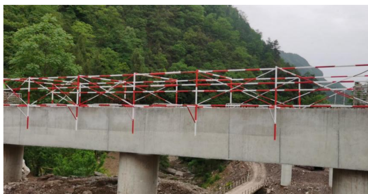
图 1 盖梁顶部临时护栏大样图
