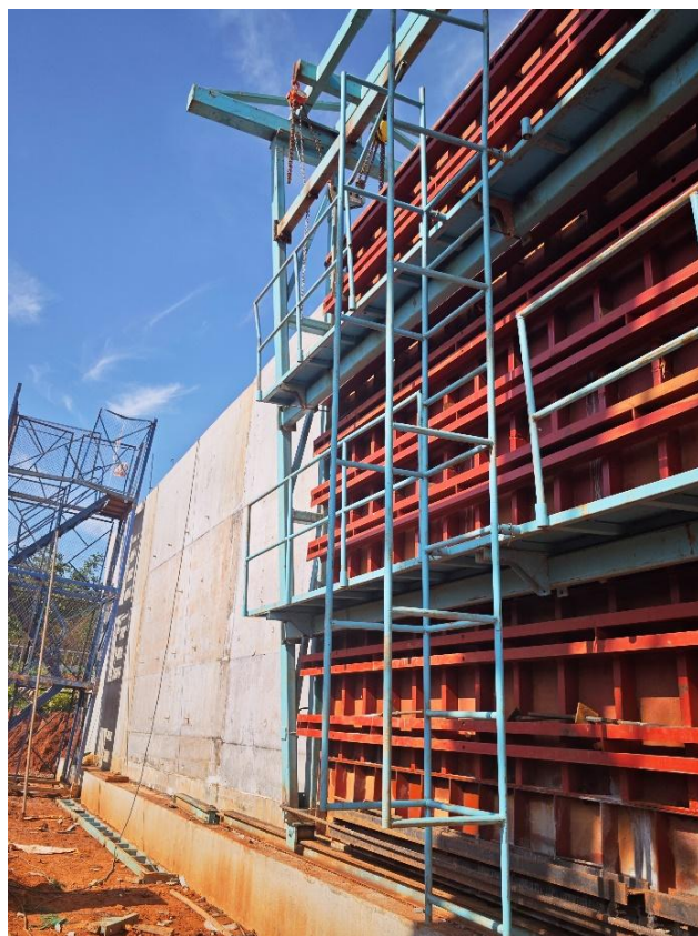
图 7 台车操作平台安全防护
