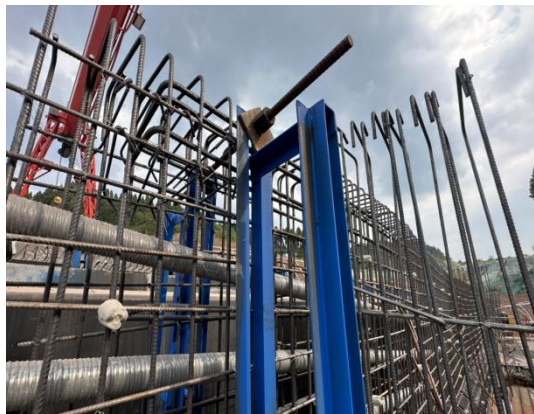
图 2 T 梁钢筋防倾覆装置正面
