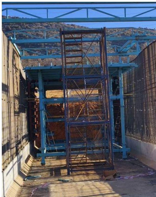
图 3 内模台车及人员上下通道
