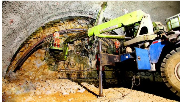
图 4 拱锚喷一体台车作业
