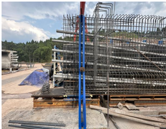
图 1 T 梁钢筋防倾覆装置侧面
