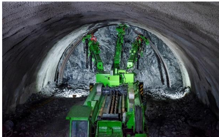
图 3 拱架安装台车作业
