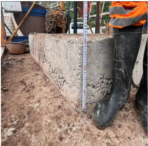
图7 人工挖孔桩锁口设置高于 30cm
