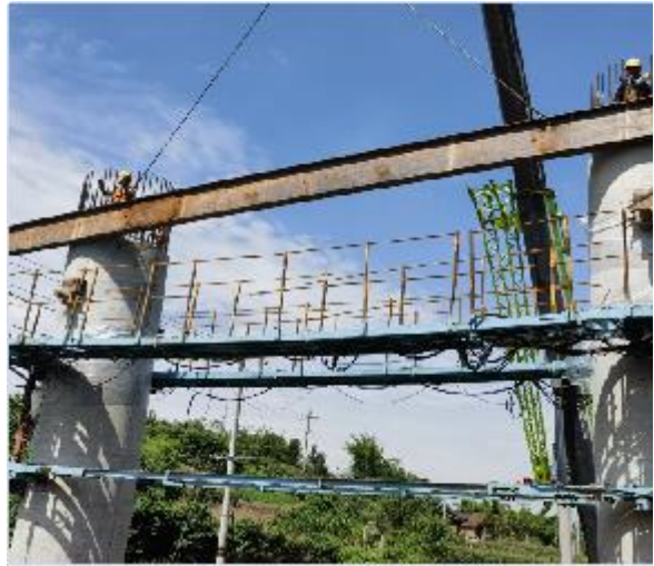
图 2 有平台后穿心棒施工工艺
