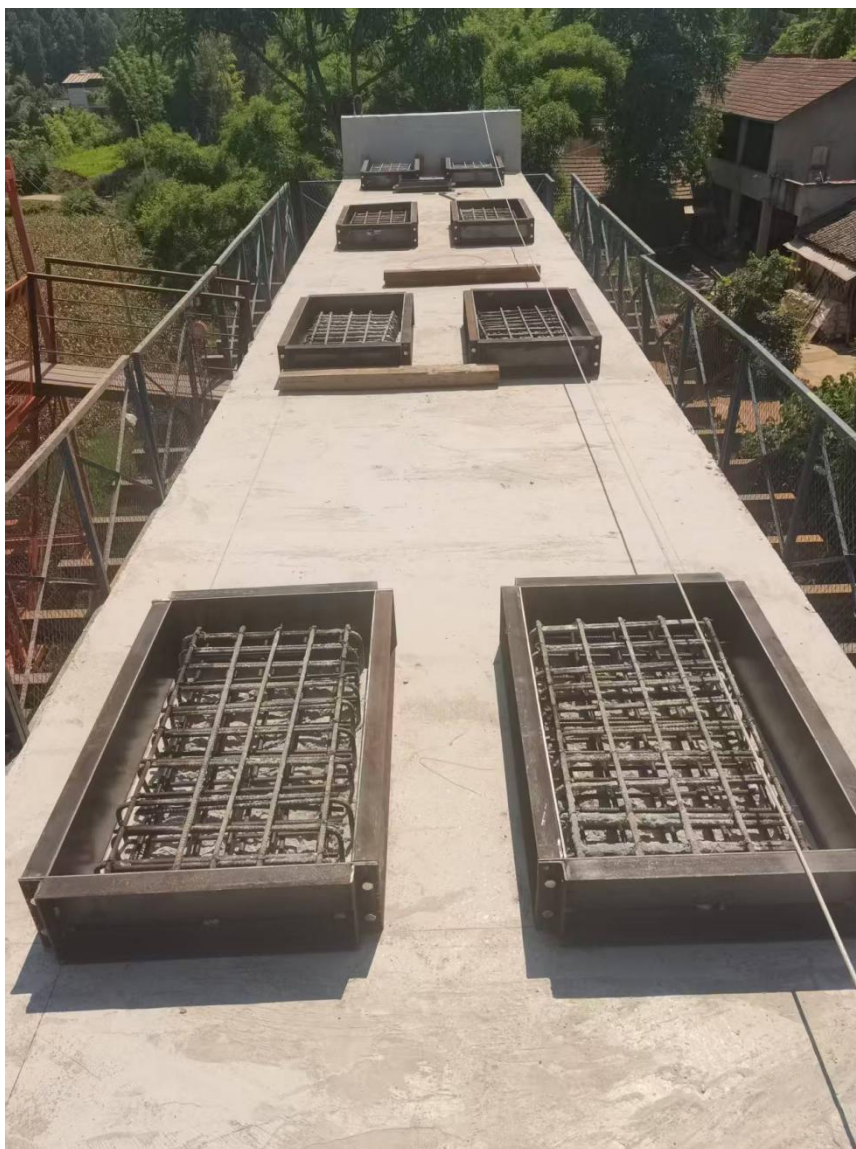
图 2 垫石施工利用盖梁防护体系
