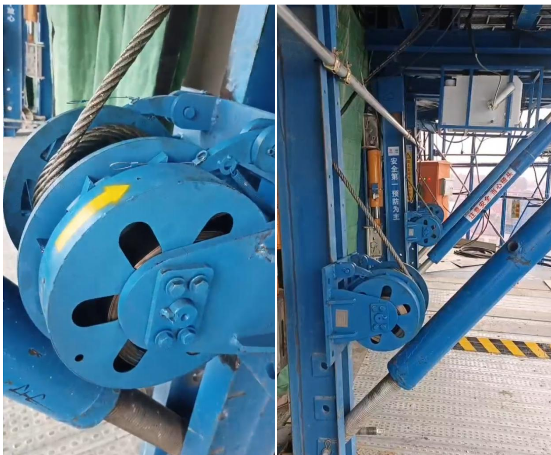
图 1 全自动液压爬模防坠装置现场安装示例
