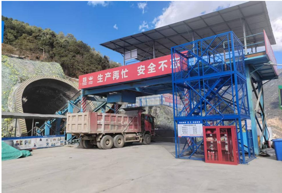
图 1 隧道渣出渣系统
