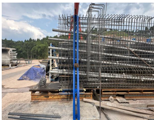
图 1 T 梁钢筋防倾覆装置侧面
