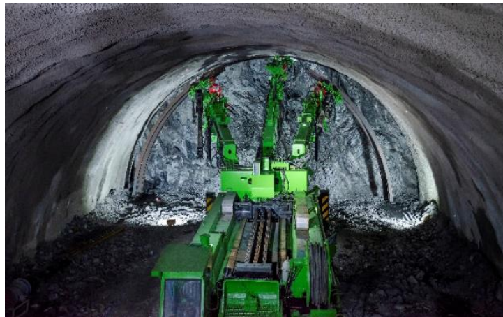
图3 拱架安装台车作业
