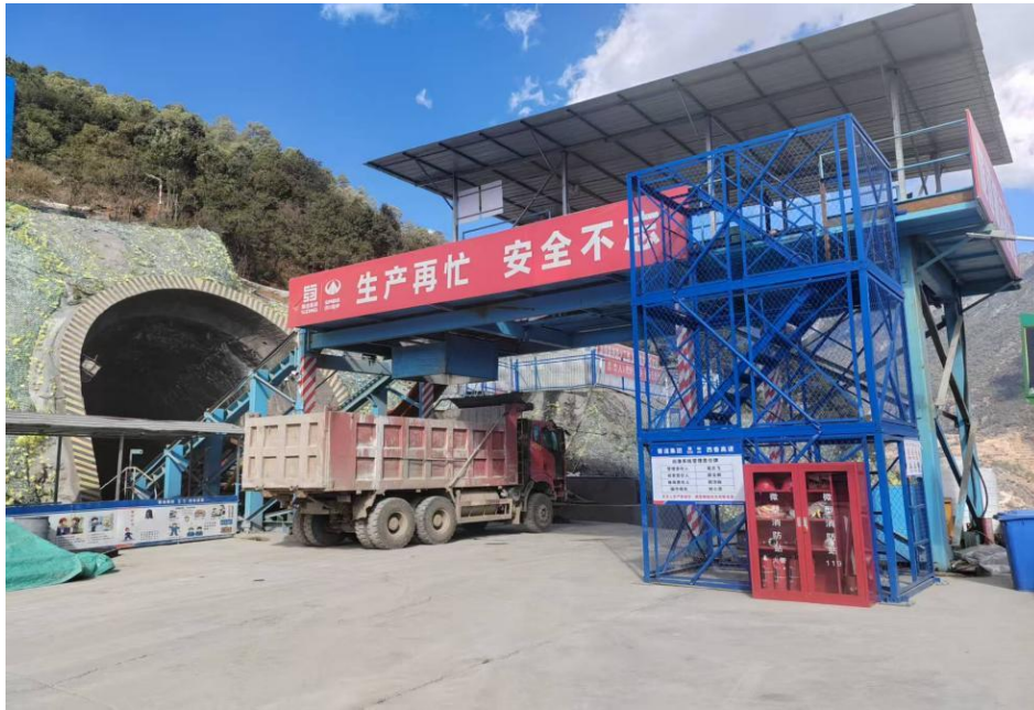
图 1 隧道锚出渣系统
