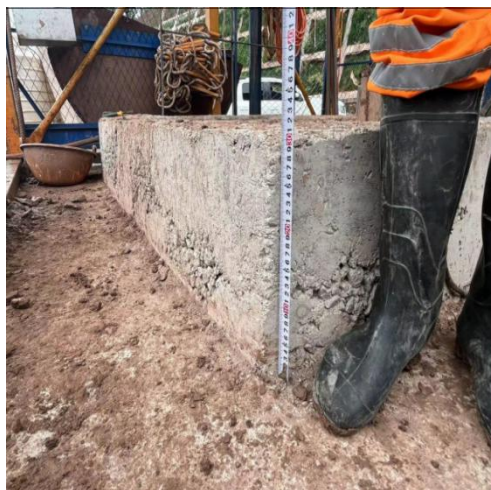
图7 人工挖孔桩锁口设置高于30cm
