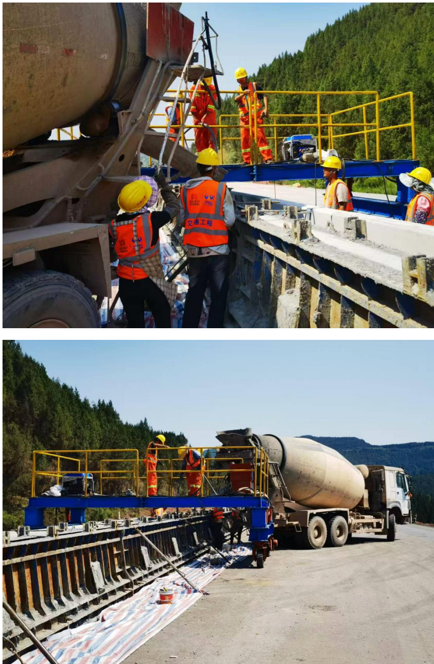
图 1 全液压式中央砼护栏安全操作平台现场
