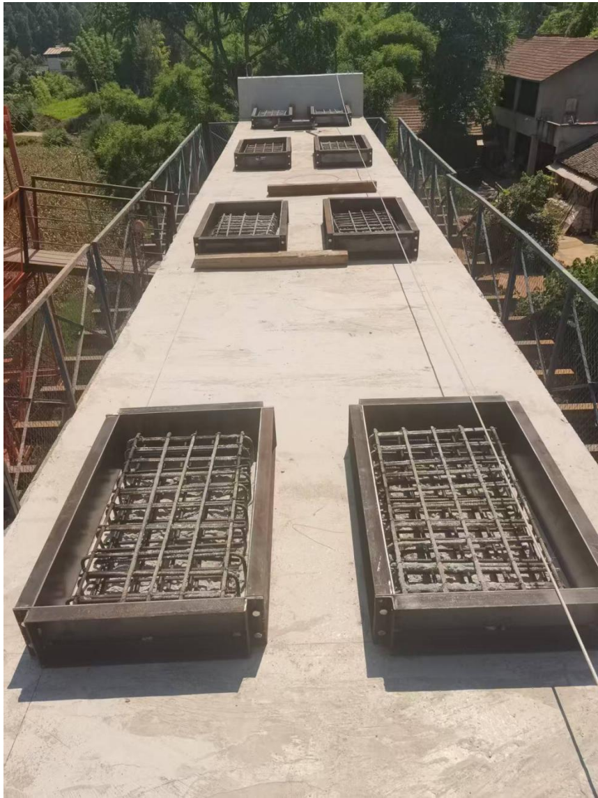
图2 垫石施工利用盖梁防护体系
