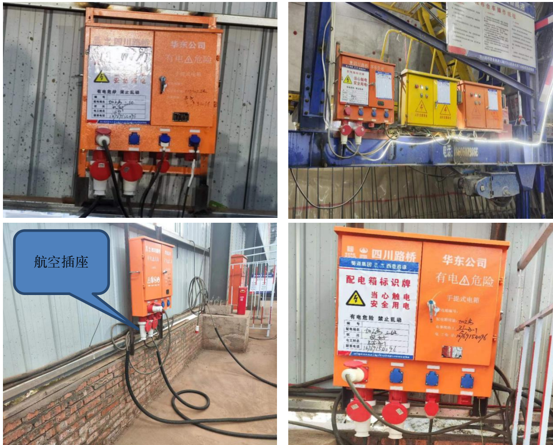
图2 配备装配式三级配电箱并上墙
