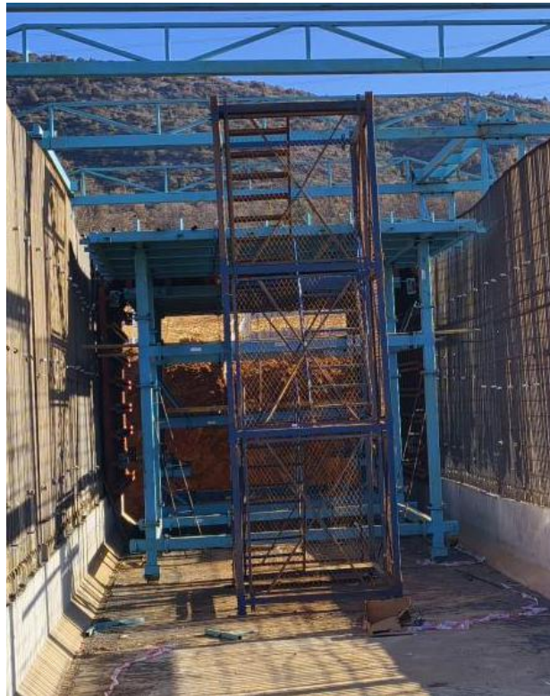
图3 内模台车及人员上下通道
