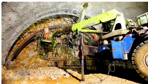
图4 拱锚喷一体台车作业
