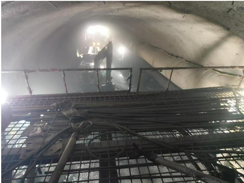
图2 现场施工照片（防护栏杆安拆）
