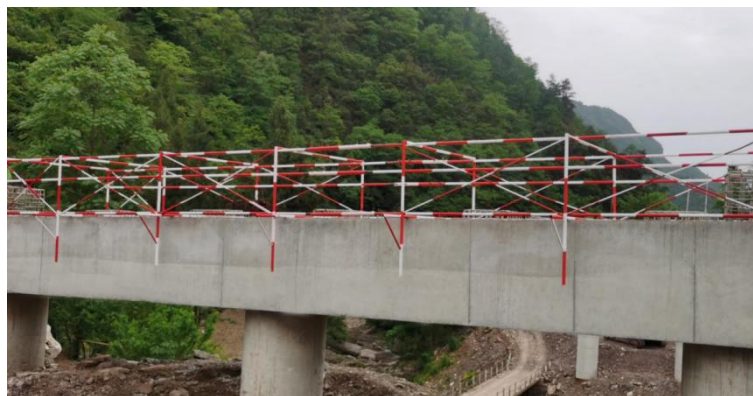
图 1 盖梁顶部临时护栏大样图
