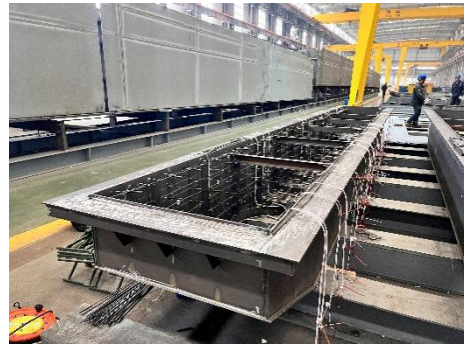
图 2 盖梁成型照片
