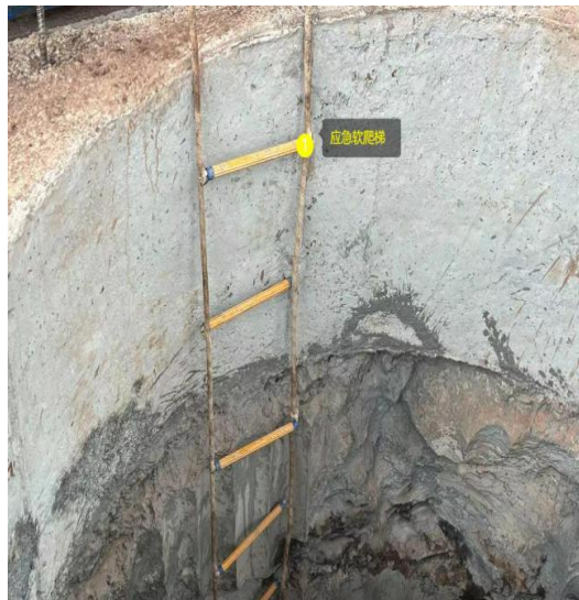
图6 人工挖孔桩设置应急爬梯
