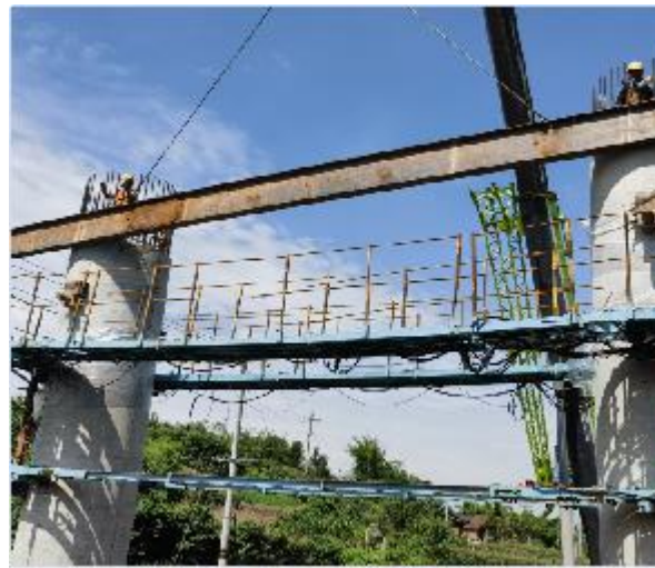
图 2 有平台后穿心棒施工工艺
