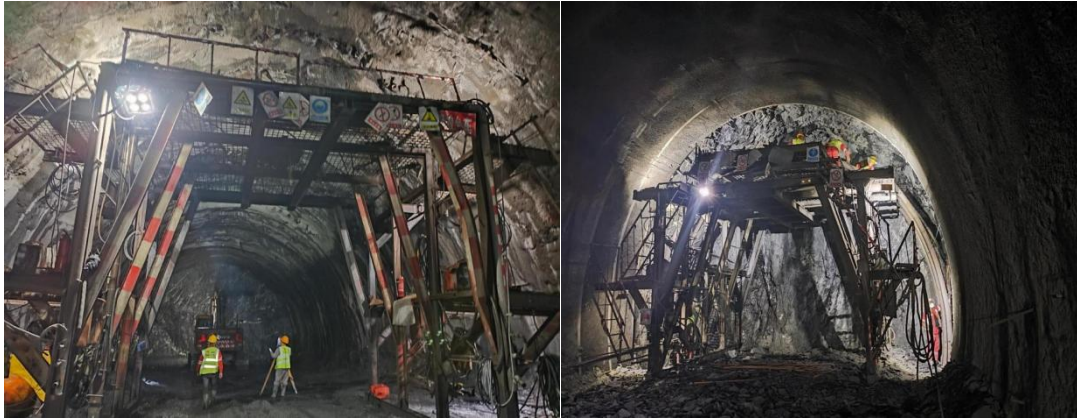
图1 改装前，开挖台车临边活动防护栏杆采用承插式
