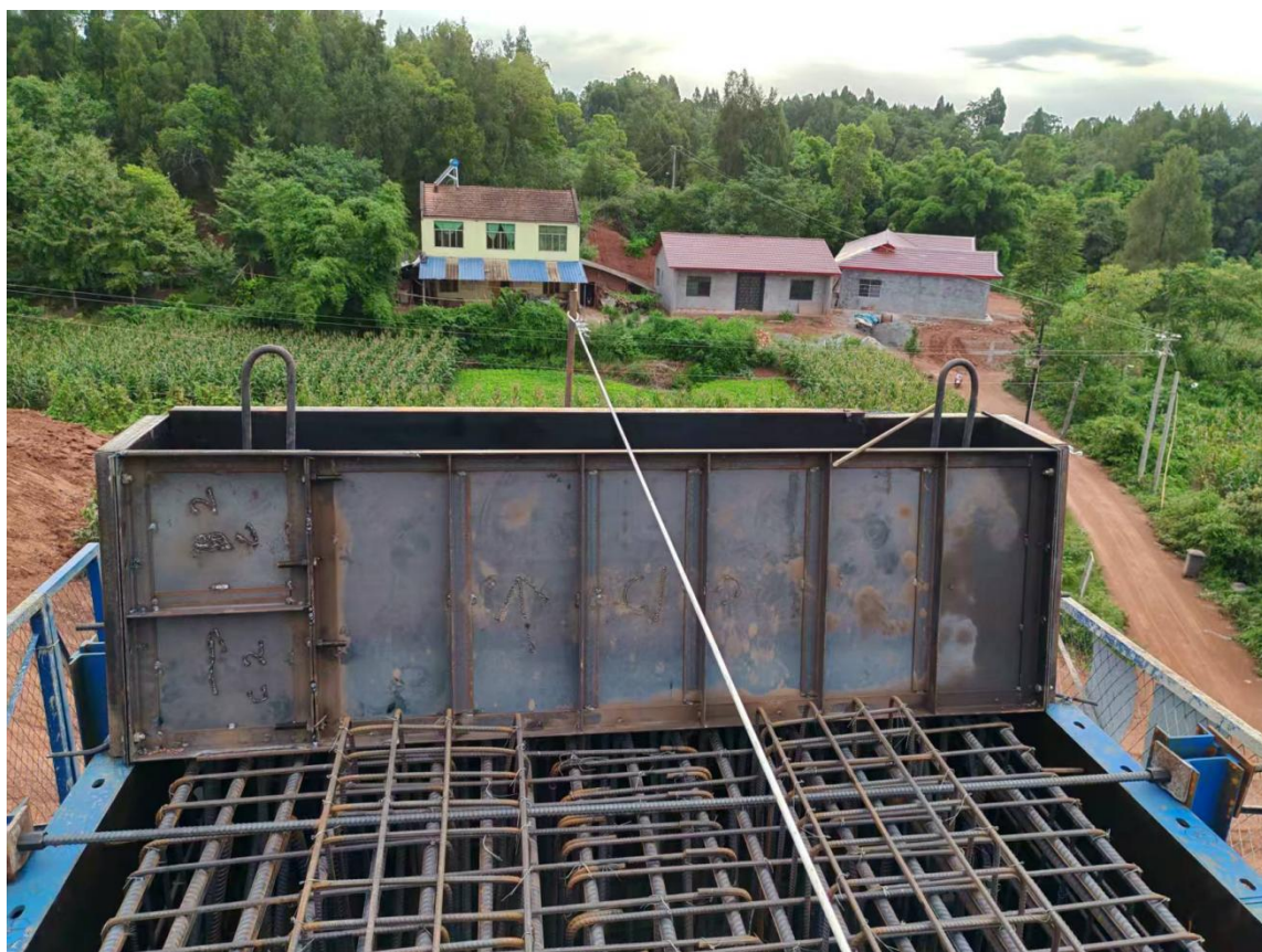
图1 挡块模板与盖梁侧模刚性连接
