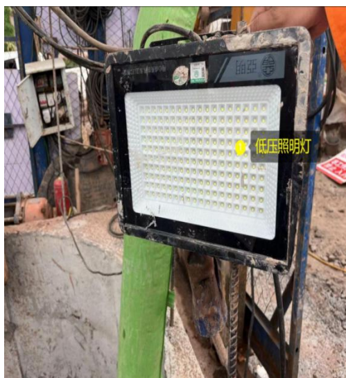
图5 人工挖孔桩设置低压照明灯
