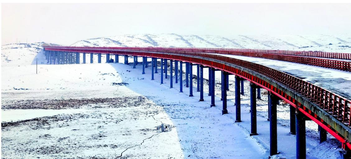
纤维混凝土桥面铺装技术应用
