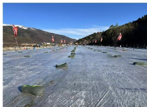
及时洒透层油+薄膜覆盖 防高原强光干燥裂纹
