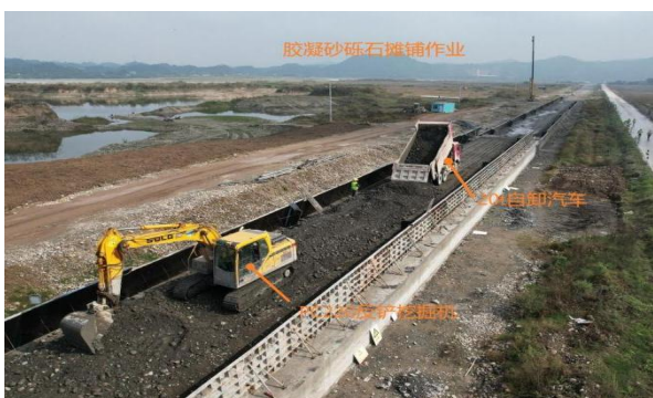
胶凝砂砾石摊铺作业
