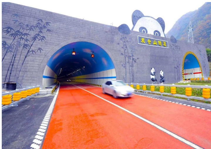
技术应用项目—米仓山隧道建设项目
