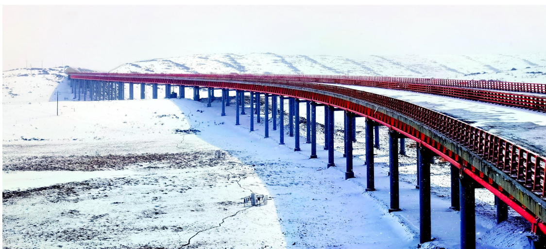
纤维混凝土桥面铺装技术应用
