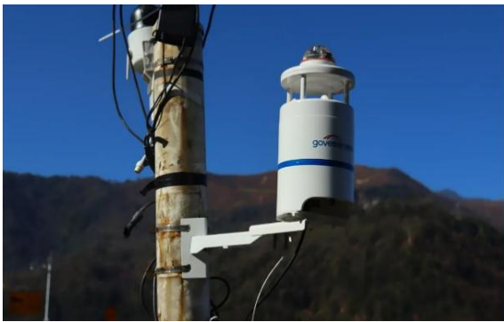
交通基础设施长期性能科学观测网试点观测点
