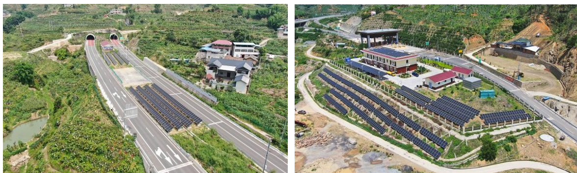
高速公路分布式光伏发电
