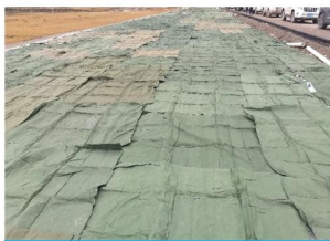
节水养生膜+土工布+棉被覆盖 防高原大温差疲劳破坏裂纹
