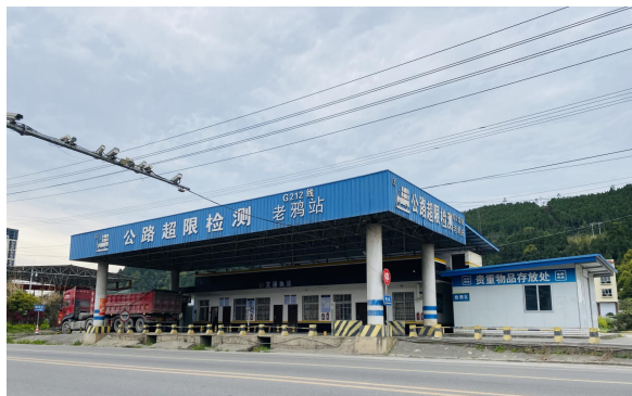
固定超限检测站
