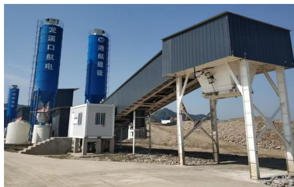
胶凝砂砾石拌合站
