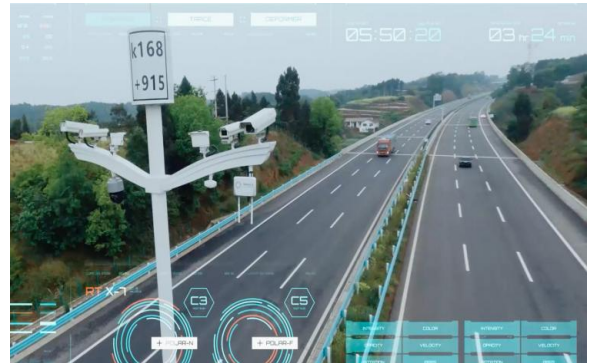
成宜高速公路上的“智慧杆”
