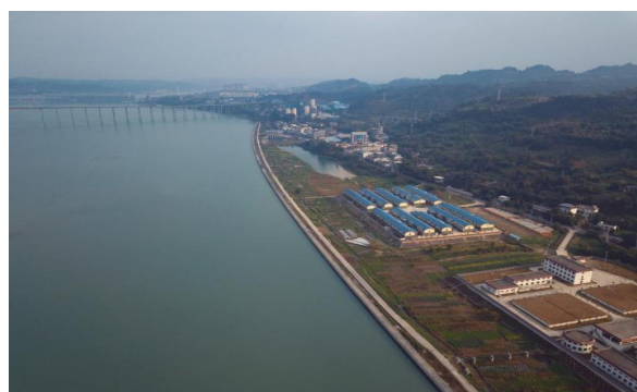
胶凝砂砾石堤防完建全貌
