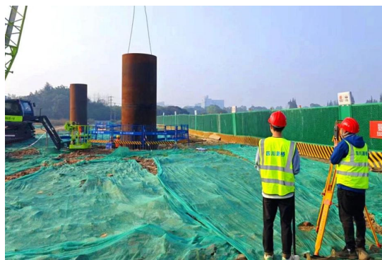
钢管混凝土墩柱
