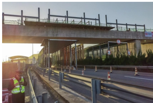
跨越式涉路施工
