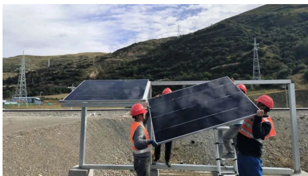
久马高速碛化钼发电智能融雪化冰系统
