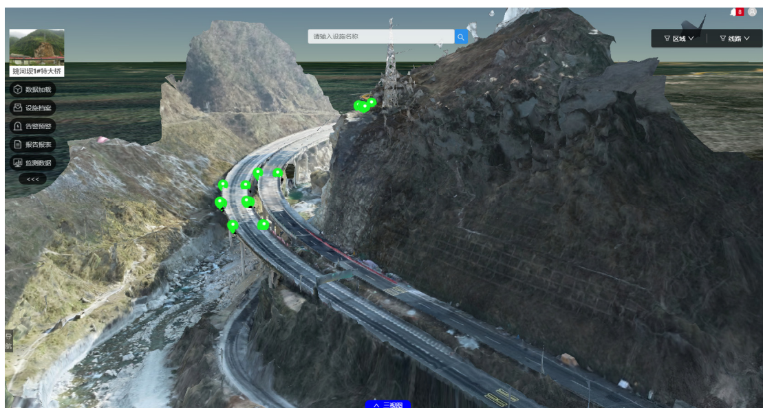
雅西高速姚河坝特大桥安全监测平台
