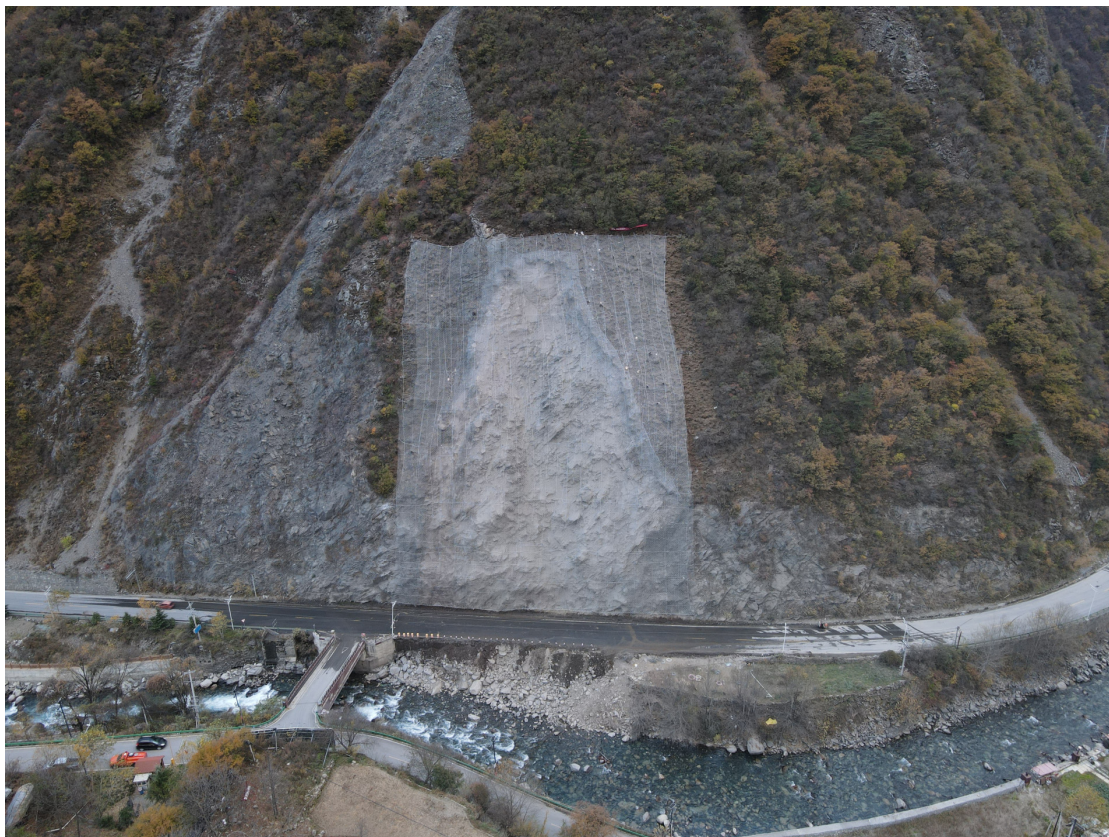
G317 线古尔沟高位崩塌治理工程
