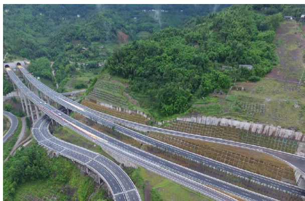
仁沐新马边支线平乐互通顺层高边坡
