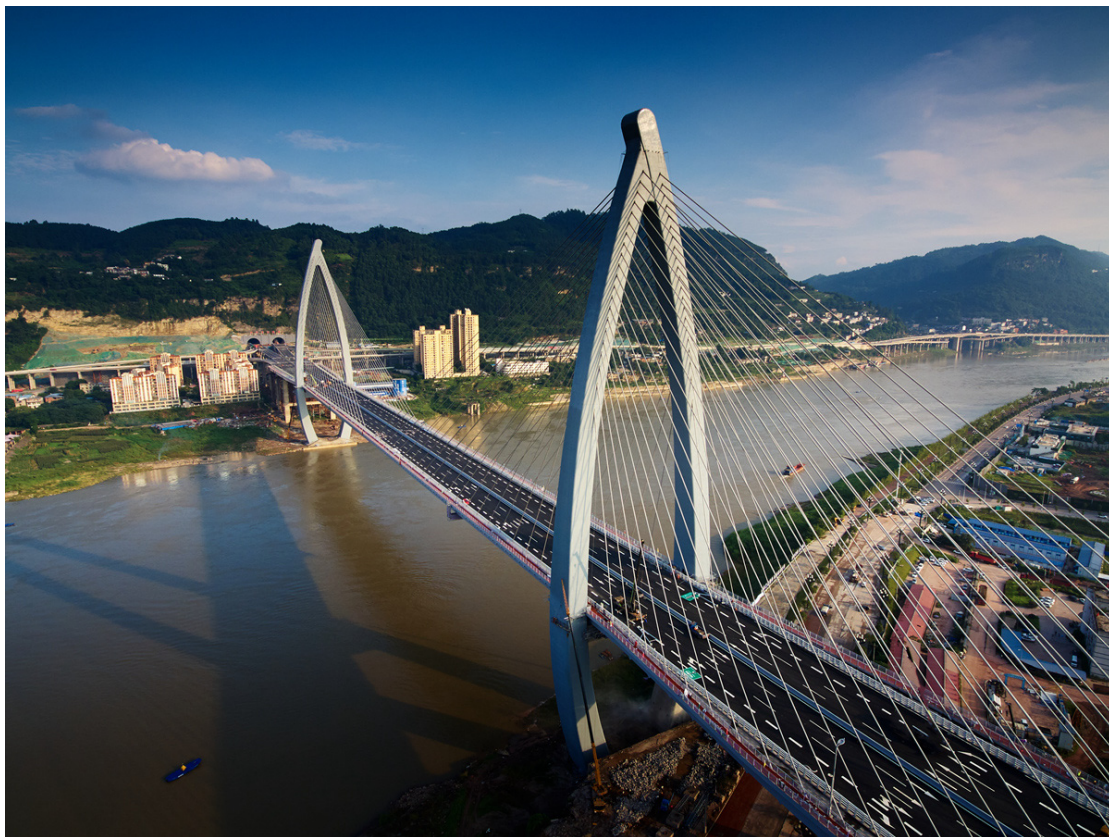
宜宾盐坪坝长江大桥
