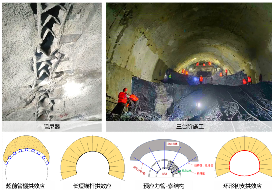
软岩大变形隧道机械化配套施工工艺
