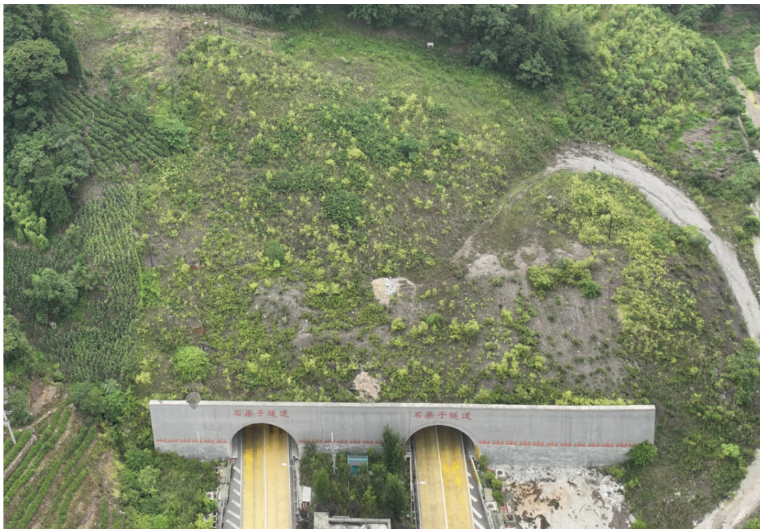
仁沐新高速石梁子隧道
