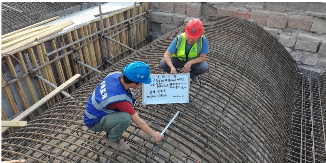
G347 小平溪大桥病害整治工程
