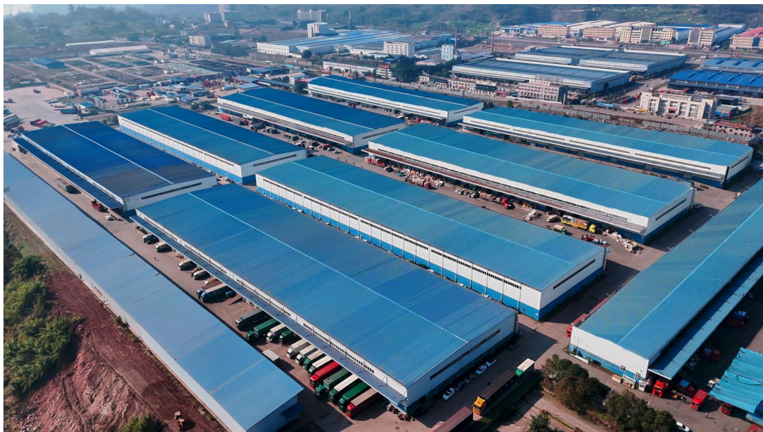
达州公路物流港闲置屋顶光伏发电设备
