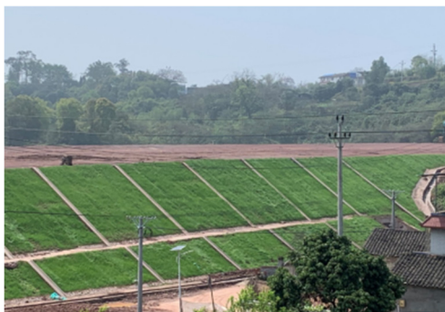
填方路基边坡生态防护
