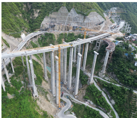
沿江高速安寨坪互通高边坡
