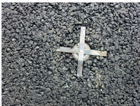
久马高速碛化钼发电智能融雪化冰系统
