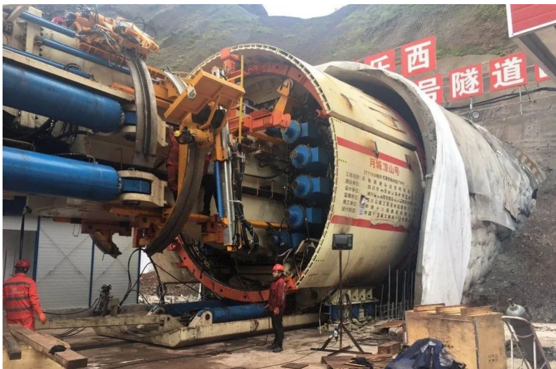
大凉山一号隧道“月城凉山号”隧道 TBM 施工
