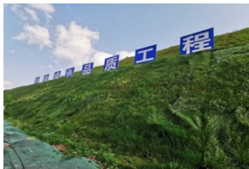
挖方路堑边坡生态防护
